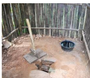
完成したトイレ
