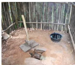
完成したトイレ
