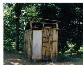
完成した家庭用トイレ (外観)
