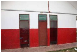
修復された学校のトイレ
