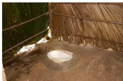
完成した家庭用トイレ
